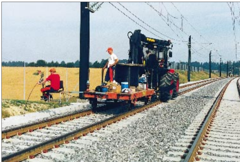
På den norska marknaden finns stor efterfrågan på duktiga järnvägsentreprenörer. Utmed Gardemobanan har Gösta Malmquist Entreprenad bl a lagt 70 mil kabel.
