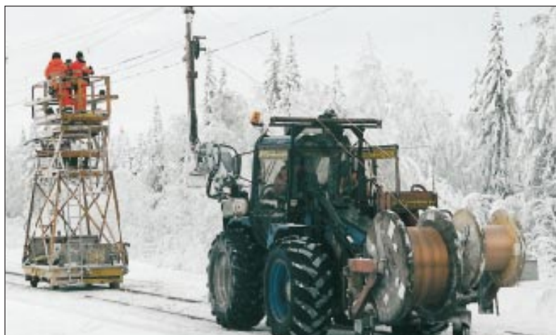
Gösta Malmqvists hydrauliska lindragare ett patent som mognat i det praktiska arbetet. Foto Gösta Malmquist.
