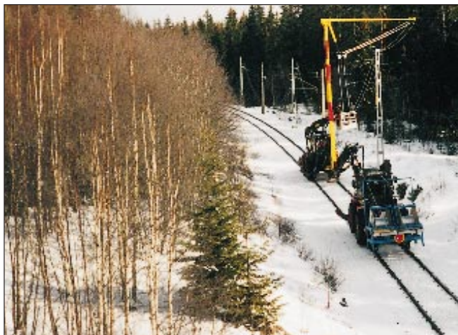
Linor på väg upp. Om det behövs, "kliver" man enkelt av spåret.
